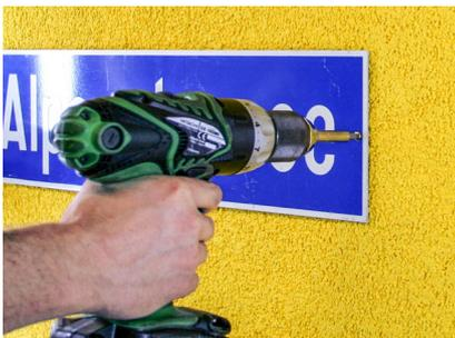
Anbauteile in der Montagerondelle DoRondo®-PE verschrauben.
