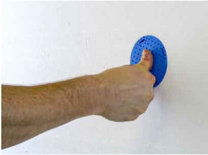
Montagerondelle DoRondo®-PE dämmplattenbündig in die Ausfräsung pressen.
