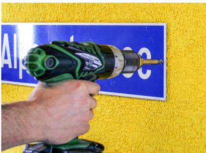
Avvitare l'avvitamento del componente nella rondella di fissaggio DoRondo®-PE.
