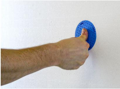
Premere la rondella di fissaggio DoRondo®-PE a filo dei pannelli isolanti nella sezione fresata.
