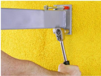
Anbauteil mit Schraubdübeln im Mauerwerk verankern.
