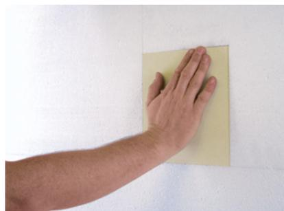
Auf die Klebefläche des Montagequaders Quadroline®-PU Klebemörtel aufziehen. Element muss vollflächig auf den tragfähigen Untergrund verklebt werden.
