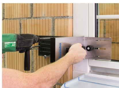
Praticare il primo foro. Trapanare i muri con mattoni forati senza utilizzare la funzione percussione. Inserire il perno di fissaggio nel foro corrispondente e fissare la staffa di montaggio pannelli TRA-WIK®-PU.
