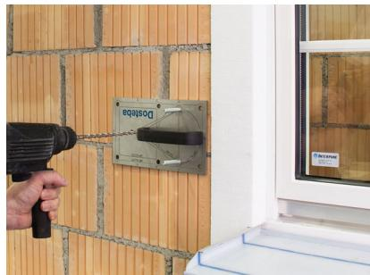
Utilizzando la dima di foratura UMP® / TRA-WIK® / TWL® praticare il secondo foro. Per fissare la dima di foratura, infilare un'asta filettata per iniezione nel primo foro.
