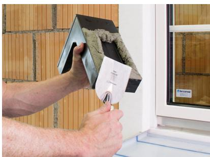
Auf die Klebefläche des Tragwinkels TRA-WIK®-PU Klebemörtel aufziehen. Element muss vollflächig auf den tragfähigen Untergrund verklebt werden.
