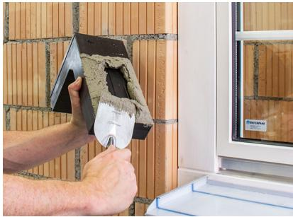
Appicare della malta adesiva sulla superficie d'incollaggio della staffa di montaggio pannelli TRA-WIK®-PU.
