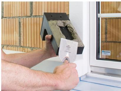
Applicare della malta adesiva sulla superficie d'incollaggio della staffa di montaggio pannelli TRA-WIK®-PU.
