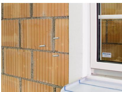
Gewindestangen setzen und genau ausrichten. Injektions-Mörtel aushärten lassen. Bei Mauerwerk mit Lochsteinen müssen zwingend Injektions-Ankerhülsen verwendet werden.
