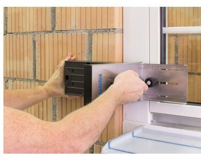
Tenere le staffe di montaggio pannelli TRA-WIK®-PU con il calibro di posizionamento inserito all'altezza marcata e portare il calibro di posizionamento a contatto con il telaio della finestra. Il segno sul muro deve essere visibile attraverso la fessura centrale del calibro di posizionamento. La battuta deve aderire bene al telaio della finestra.
