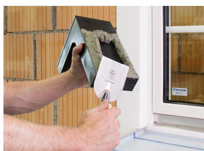
Applicare della malta adesiva sulla superficie d'incollaggio delle staffe di montaggio pannelli TRA-WIK®-PU.
