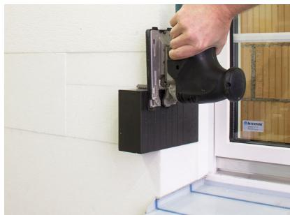
Tragwinkel TRA-WIK®-PU fassadenbündig ablängen.
