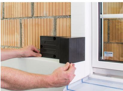
Tragwinkel TRA-WIK®-PU dämmplattenbündig anpressen.
