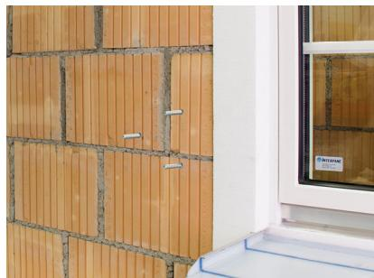
Posizionare le aste filettate e allinearle esattamente. Lasciar indurire la malta iniettata. Per quanto riguarda le opere murarie, utilizzare tassativamente delle bussole d'ancoraggio per iniezione.
