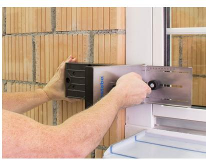
Tragwinkel TRA-WIK®-PU mit aufgeschobener Setzlehre auf die eingezeichnete Höhe halten und Setzlehre bis an den Fensterrahmen führen. Der Strich auf dem Mauerwerk muss durch den mittigen Schlitz in der Setzlehre sichtbar sein. Der Anschlag muss am Fensterrahmen sauber aufliegen.
